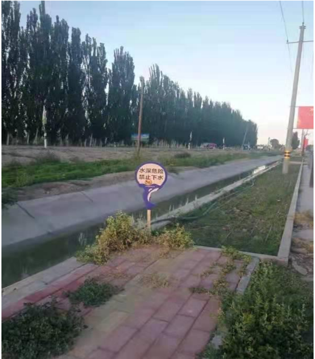
附件 3：渠道防渗改造工程现场效果图片
