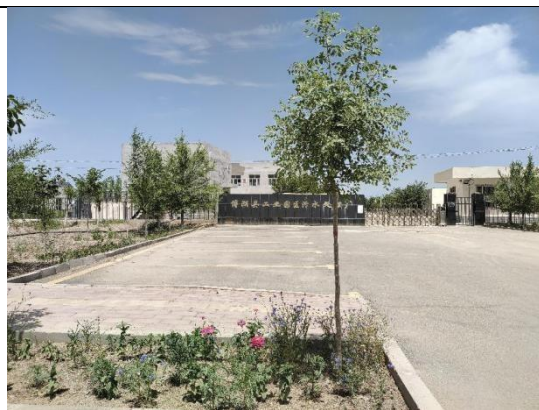
园区污水处理厂
