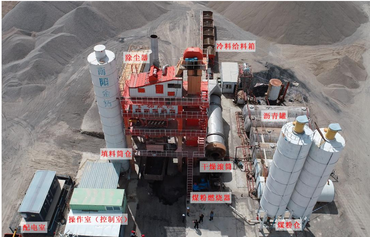
图 3 沥青搅拌站全貌图
