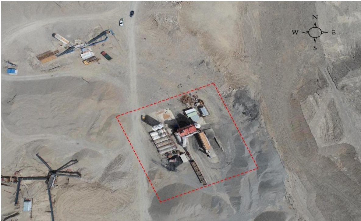
图2 沥青混合料搅拌设备俯瞰图（无人机航拍）
